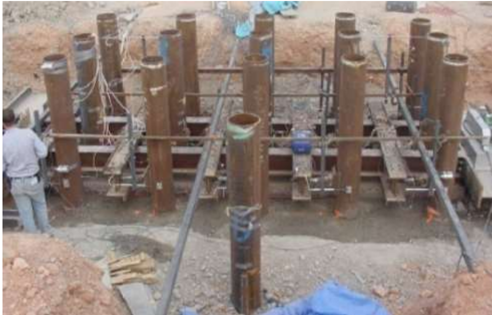
Figura 5.9: Foto do local onde foram instaladas as estacas para o estudo experimental. (WALSH 2005)
