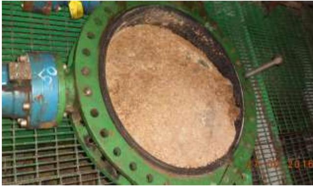
Figura 8: Válvula com incrustação
