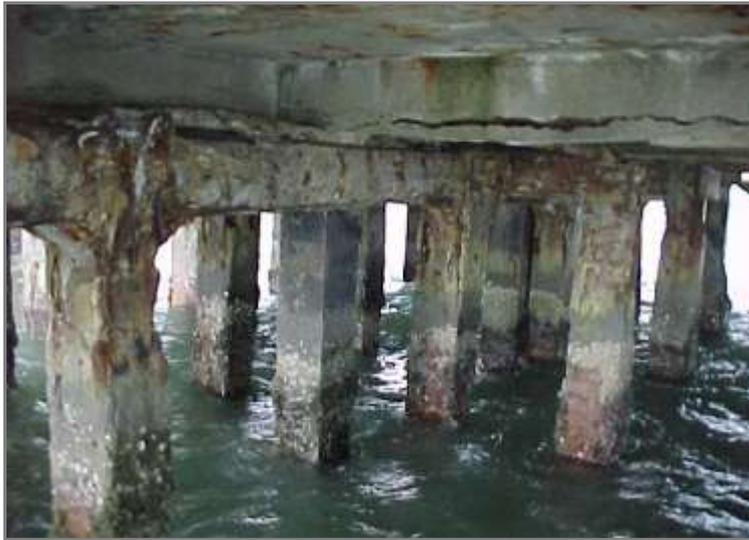
Figura 2.7 - Corrosão de armaduras e degradação de concreto no píer localizado em Ilhabela-SP
